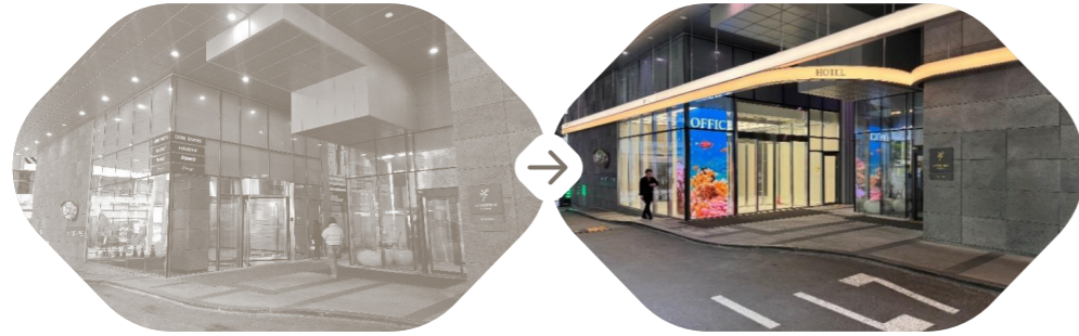
오피스 진입로 펜던트형 사인 설치
