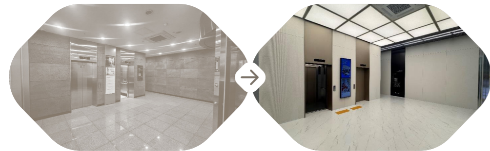
오피스로비 바닥/벽체/천정체/ 우편함 교체, 자동문/ 에어커튼/EHP/ LED패널 설치
