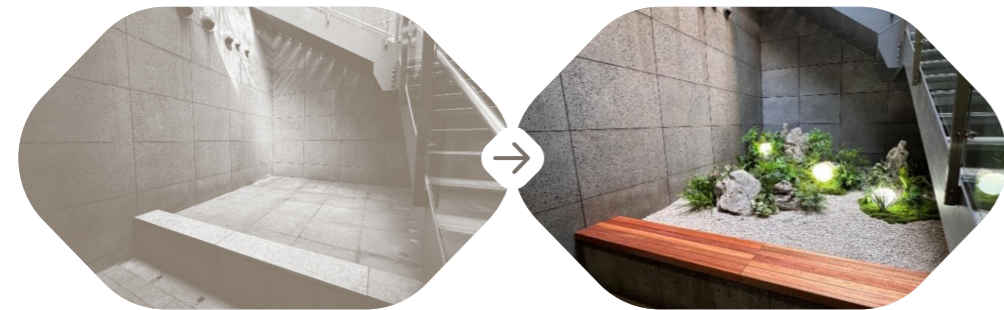
지하 선큰 벽체교체, 조경 조성, 계단 난슬립 설치
